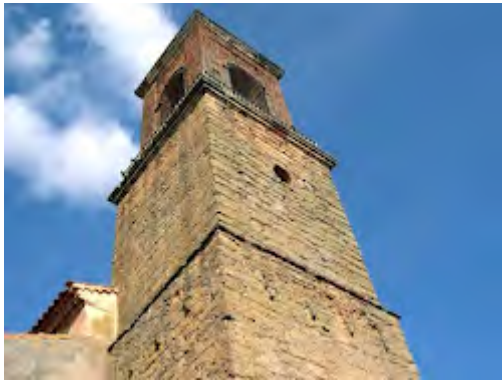
[Sillares de arenisca] Restos de un puente de la vía, en la iglesia de San Esteban del Molar.
