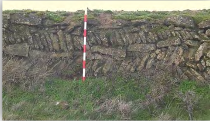
La Calzada a su paso por San Esteban Cimentación de la gran calzada de San Esteban, con casi un metro de firme de arenisca.
