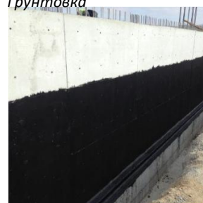
Рисунок 2: Грунтовка
