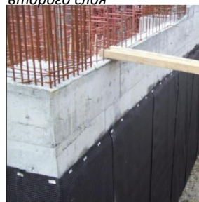
Рисунок: 4 Нанесение второго слоя
