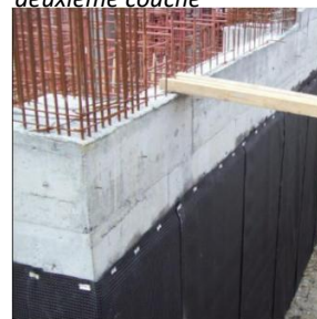
Figure 4 Application de la deuxième couche
