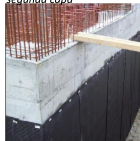
Figura: 4 Aplicación de la segunda capa
