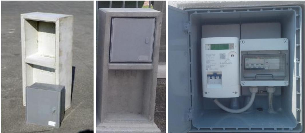
**OSS<sub>1</sub>:** le caratteristiche specifiche, le opere accessorie e la tipologia di cavidotti per “avvicinare” il punto di consegna all’impianto di sollevamento da alimentare dovranno scrupolosamente rispettare le specifiche tecniche dettate dal Gestore dell’energia.
